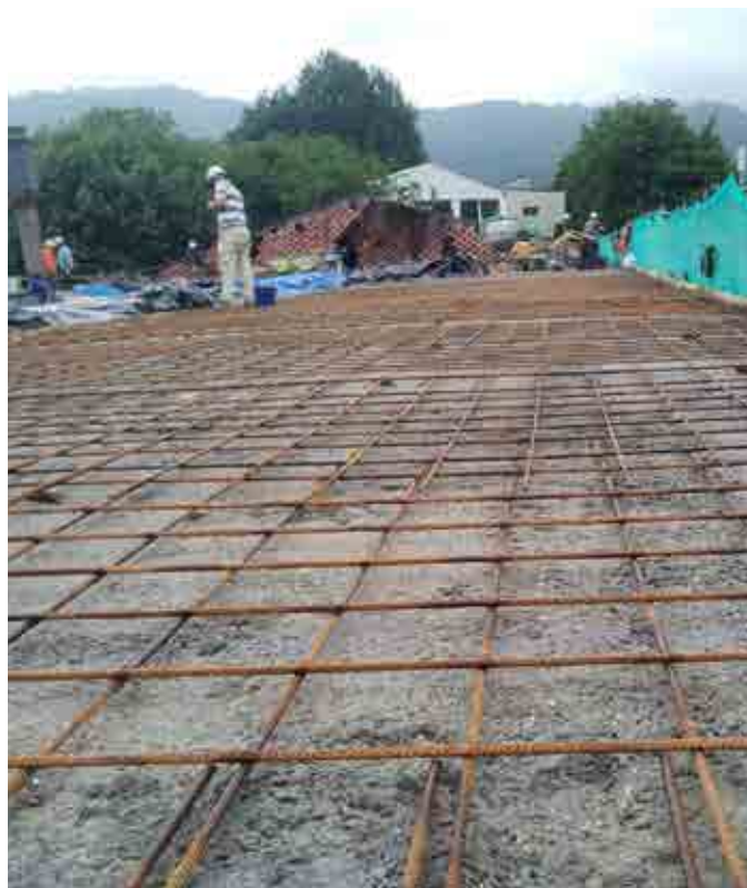
Instalación del mallazo electrosoldado antes de la proyección del Conector Químico CentroStorico con la tolva difusora.
