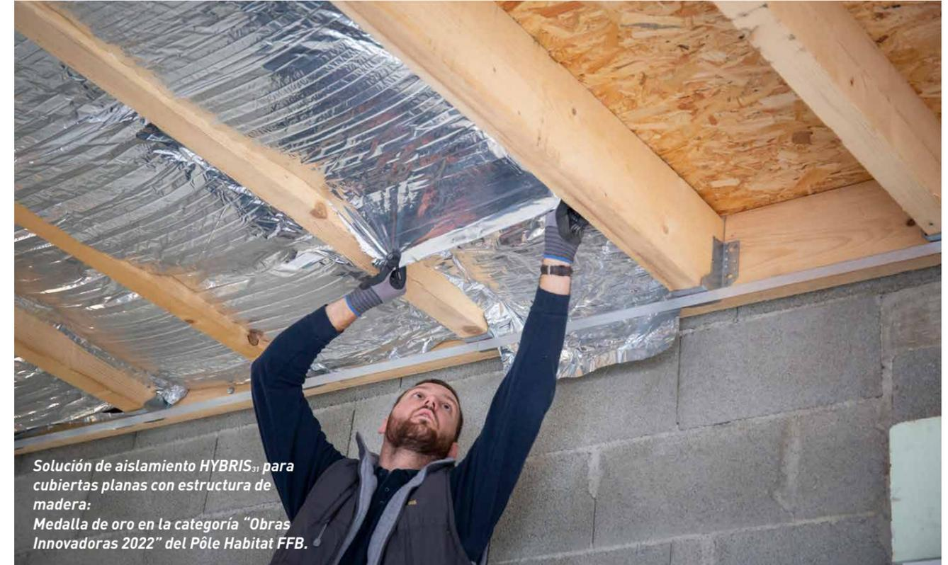
*Solución de aislamiento HYBRIS<sub>31</sub> para cubiertas planas con estructura de madera:
