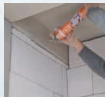
Sigillatura giunti sottili orizzontali
