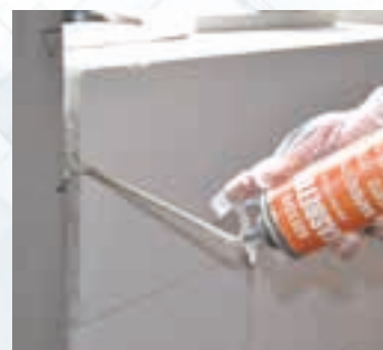
Sigillatura giunti sottili verticali
