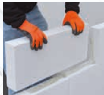
Posa di blocchi GASBETON®
