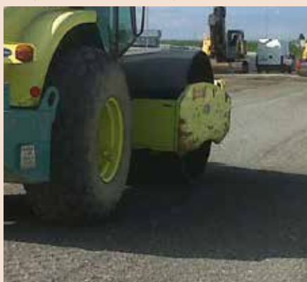
Compactación de los terraplenes ligeros.
