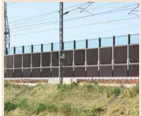
Barreras acústicas ferroviarias – Alta velocidad Milán Bolonia.
