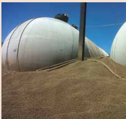
Encamado y protección de depósitos.
