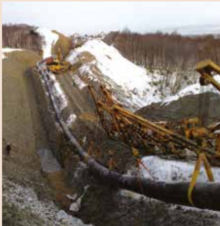
Encamado de un gasoducto - Shakalin - Rusia.
