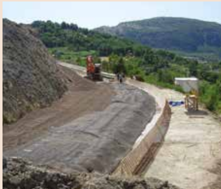
Terraplén en pendiente realizado en arcilla expandida reforzada con geomallas.
