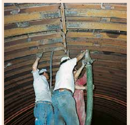
Relleno de cavidad en galería.
