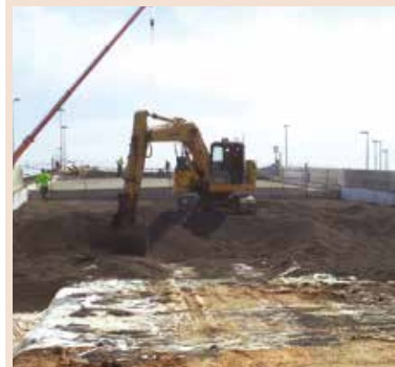
Terraplén de acercamiento al puente Puerto de Barcelona – España.
