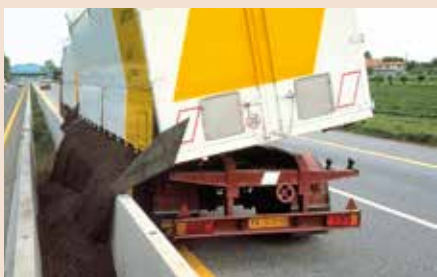
Rellenos de medianeras de arcilla expandida, antes de las plantas.
