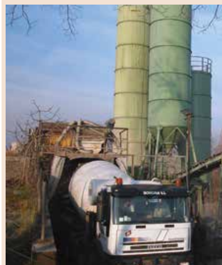
Producción de hormigón en Planta.
