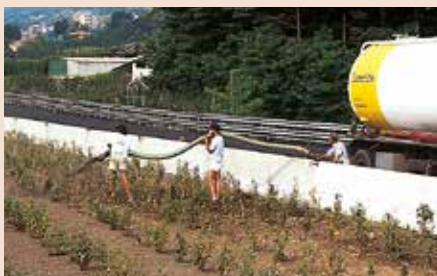
Arcilla expandida en restauración paisajística de los terrenos al margen de infraestructuras.
