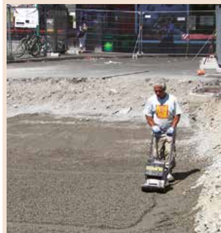
Compactación con placa vibratoria.
