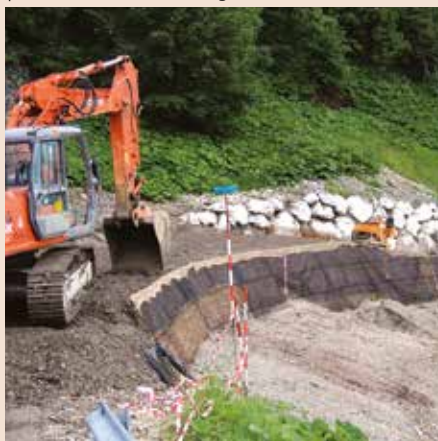
Terraplén en pendiente realizado en arcilla expandida reforzada con geomallas.
