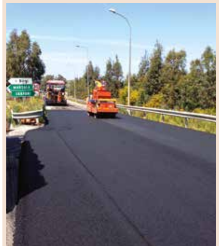
Calzadas de drenaje en autopistas.
