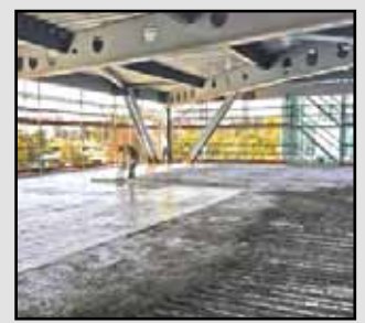
1 Hormigón estructural ligero. 2 Armadura.
