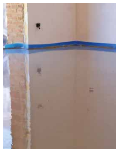
Aplicación con máquina de bombeo
