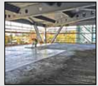
1 Hormigón estructural ligero. 2 Armadura.
